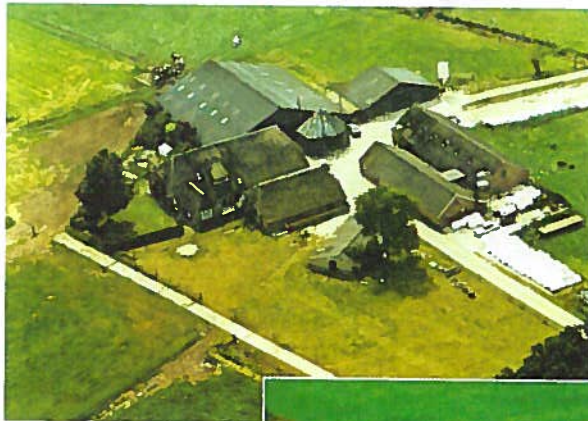
De Pauline's Hoeve op het landgoed vóór en na de sloop van voormalige bedrijfsgebouwen. De sloop vond plaats in het kader van de pilot 'Rood-voor-Groen op bestaande landgoederen'.
